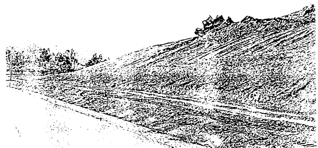
Foto 15.4. Reducción del ángulo de talud en una escombrera
