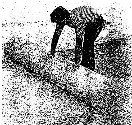
Foto 15.5. Colocación de un entramado de mimbre prefabricado.
