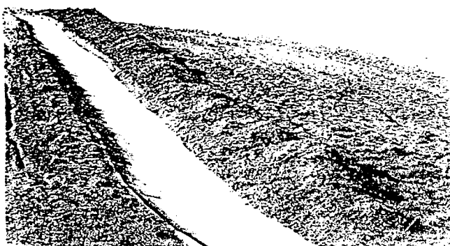
Foto 11.4. Bajante de hormigón en el talud de una escombrera.
